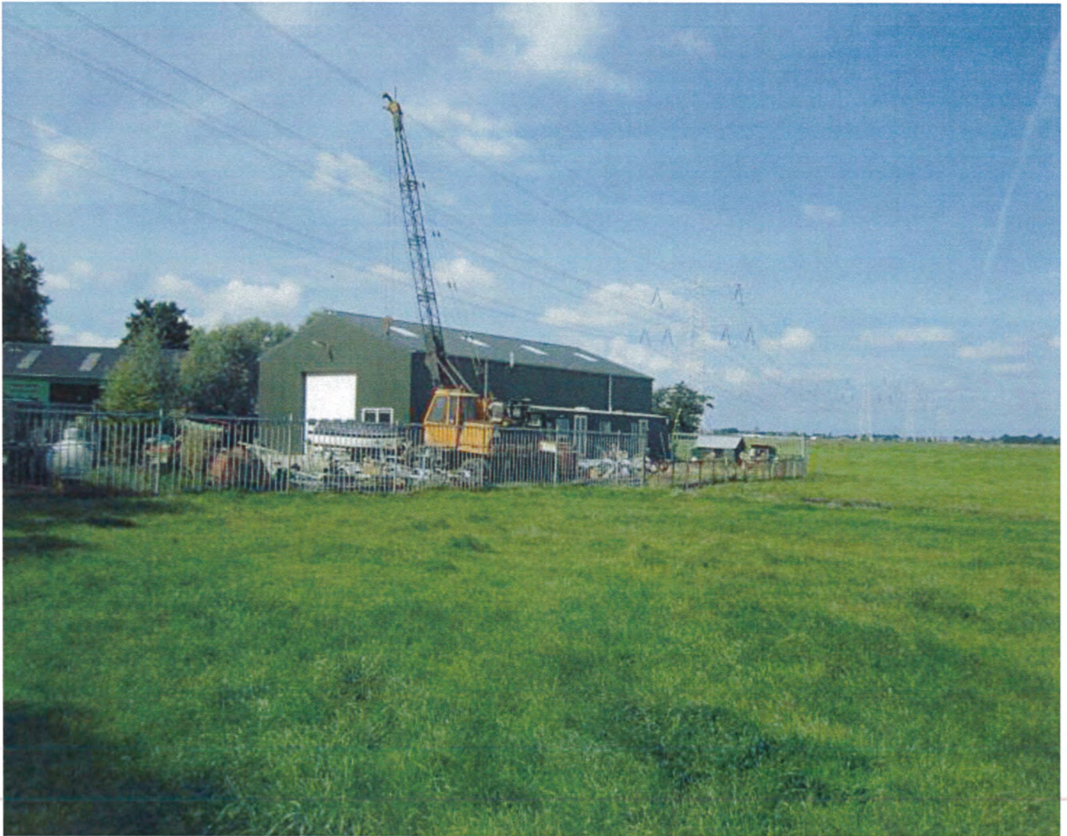
Foto 11. De nieuw gebouwde loods.
