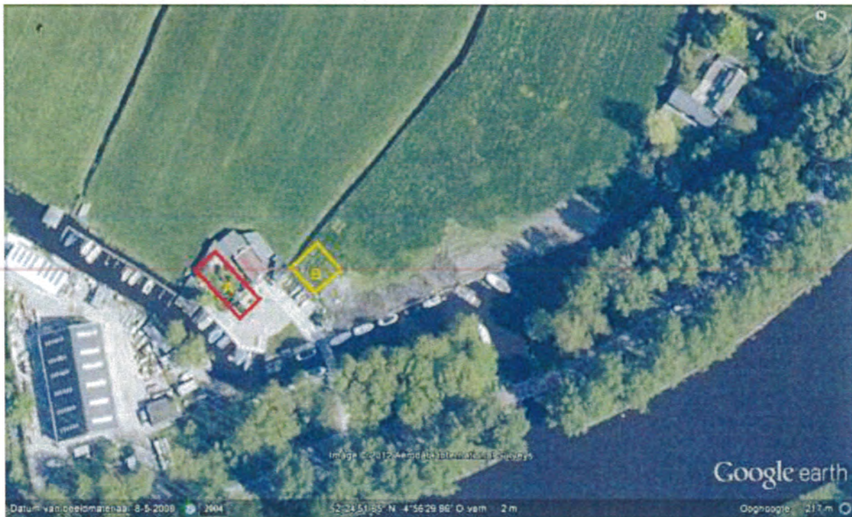
Afbeelding 4. De nieuw gebouwde loods (A) aan de Kanaaldijk 106b en de te realiseren bedrijfswoning (B). De bij de loods A zichtbare opstallen zijn inmiddels al afgebroken.
