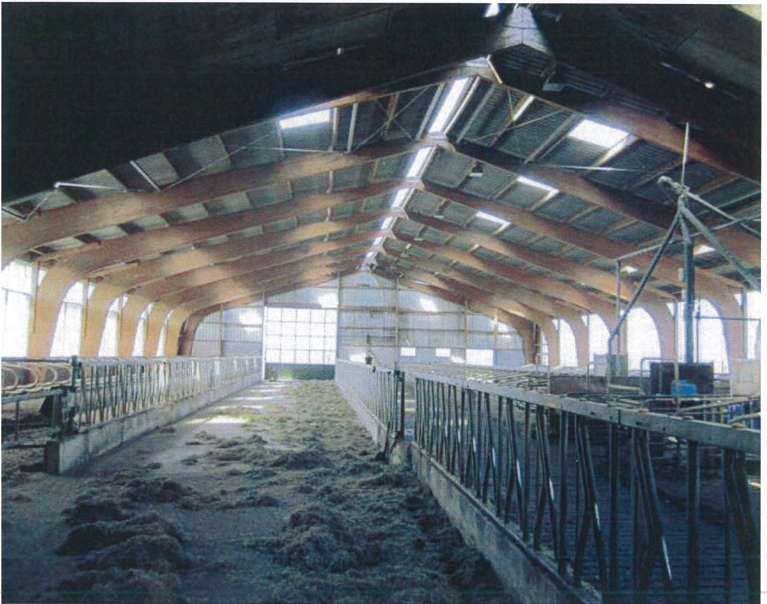
Foto 1. Interieur uitgebreide melkveestal.
