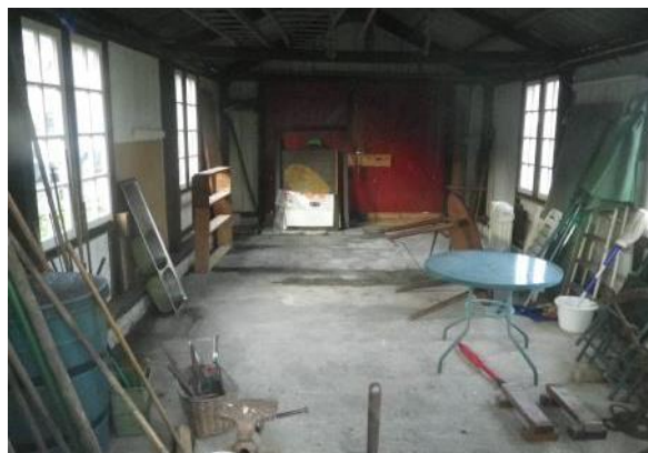
Foto 6: Garage/berging met cementvloer
