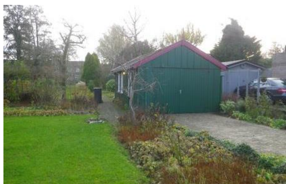
Foto 2: Garage/berging (met dakgoten)
