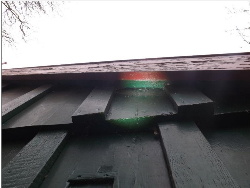
Het schuurtje is opgetrokken uit houten planken. Deze sluiten goed aan en er zijn geen openingen of kieren aanwezig. Foto: R.C.H. van Marrewijk | Ecoresult B.V.
