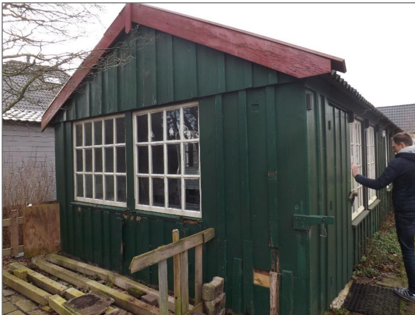
Achtergevel van het te verwijderen schuurtje binnen het plangebied gezien vanuit het westen. Foto: R.C.H. van Marrewijk | Ecoresult B.V.
