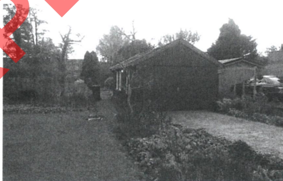
Foto 2: Garage/berging (met dakgoten)
