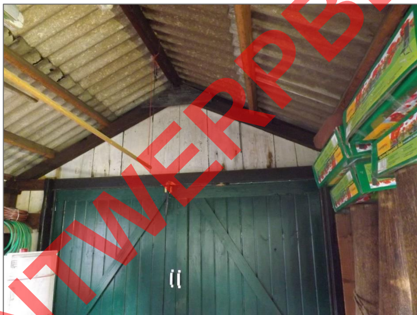
Het dak van het schuurtje bestaat uit een enkele laag van asbest golfplaten en er zijn geen tussenruimtes aanwezig waar vleermuizen gebruik van kunnen maken. Foto: [REDACTED] | Ecoresult B.V.
