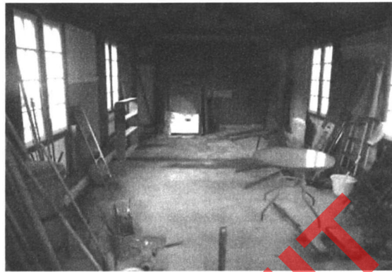
Foto 6: Garage/berging met cementvloer
