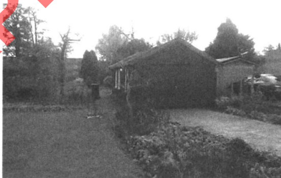
Foto 2: Garage/berging (met dakgoten)
